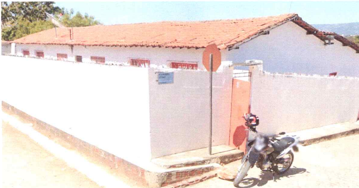
Anexo 01: Fachada do prédio Data: 24/02/2025
