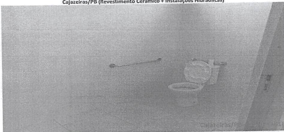
BM 06 - Contrato de Repasse 813175/2014 Ministério da Saúde – Ampliação da Policlínica Orcino Guedes – Cajazeiras/PB (Revestimento Cerâmico + Instalações Hidráulicas)
