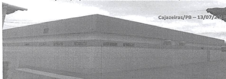
BM 06 - Contrato de Repasse 813175/2014 Ministério da Saúde – Ampliação da Policlínica Orcino Guedes – Cajazeiras/PB (Pavimentação + Pintura Externa da Obra)
