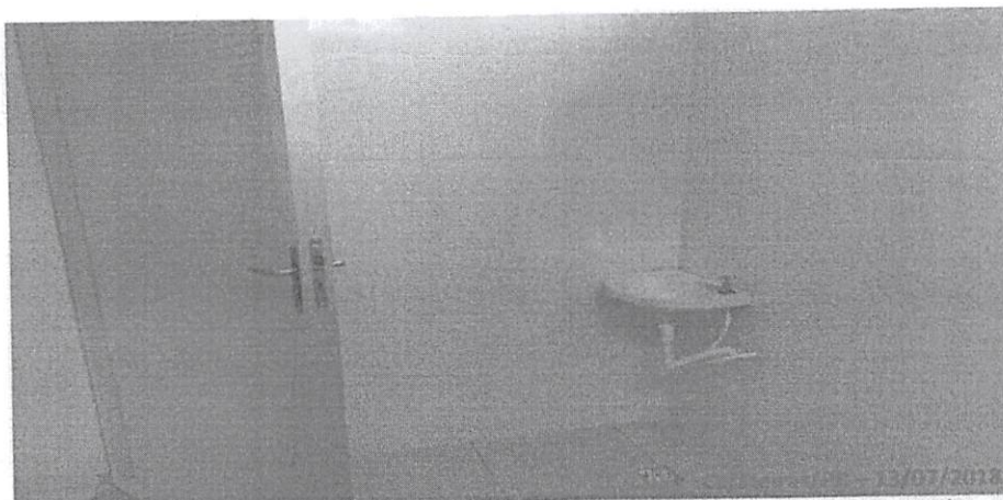
BM 06 - Contrato de Repasse 813175/2014 Ministério da Saúde – Ampliação da Policlínica Orcino Guedes – Cajazeiras/PB (Revestimento Cerâmico + Instalações Hidráulicas)
