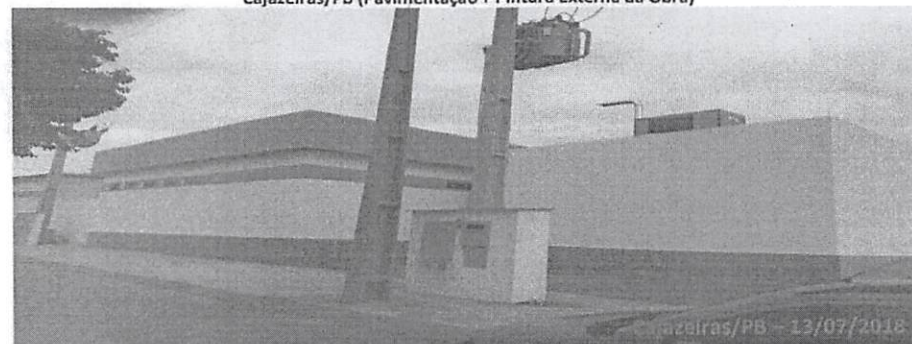
BM 06 - Contrato de Repasse 813175/2014 Ministério da Saúde – Ampliação da Policlínica Orcino Guedes – Cajazeiras/PB (Transformador Elétrico + Pintura Externa da Obra)
