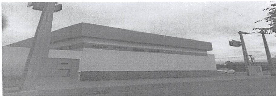
BM 06 - Contrato de Repasse 813175/2014 Ministério da Saúde – Ampliação da Policlínica Orcino Guedes – Cajazeiras/PB (Transformador Elétrico + Pintura Externa da Obra)
