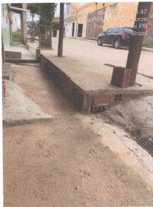
Imagens 06 & 07 - Execução de alvenaria de vedação e passeio da rua Professor Antônio Eugênio
