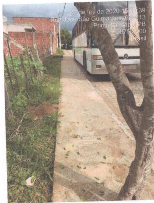
Imagens 14 – Complemento de execução de passeio da rua José Sobreira Guimarães
